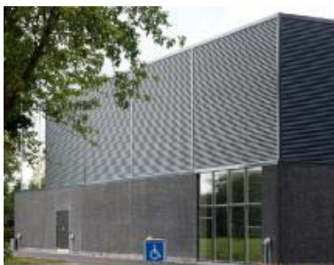
Facade af antracit grå stålplader og underetage af antracit grå beton. Ejbyhallen, Glostrup
