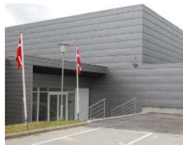
Facade af stål-kassetter. Slangerup Idræts- og Kulturcenter
