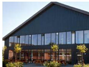
Facade af stålplader. Nørup Hallen
