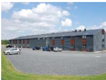
Facade og tagbelægning af stålplader
